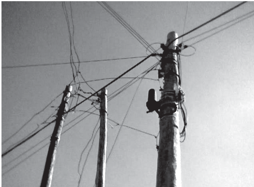
Figura 196 – Eletrificação irregular
