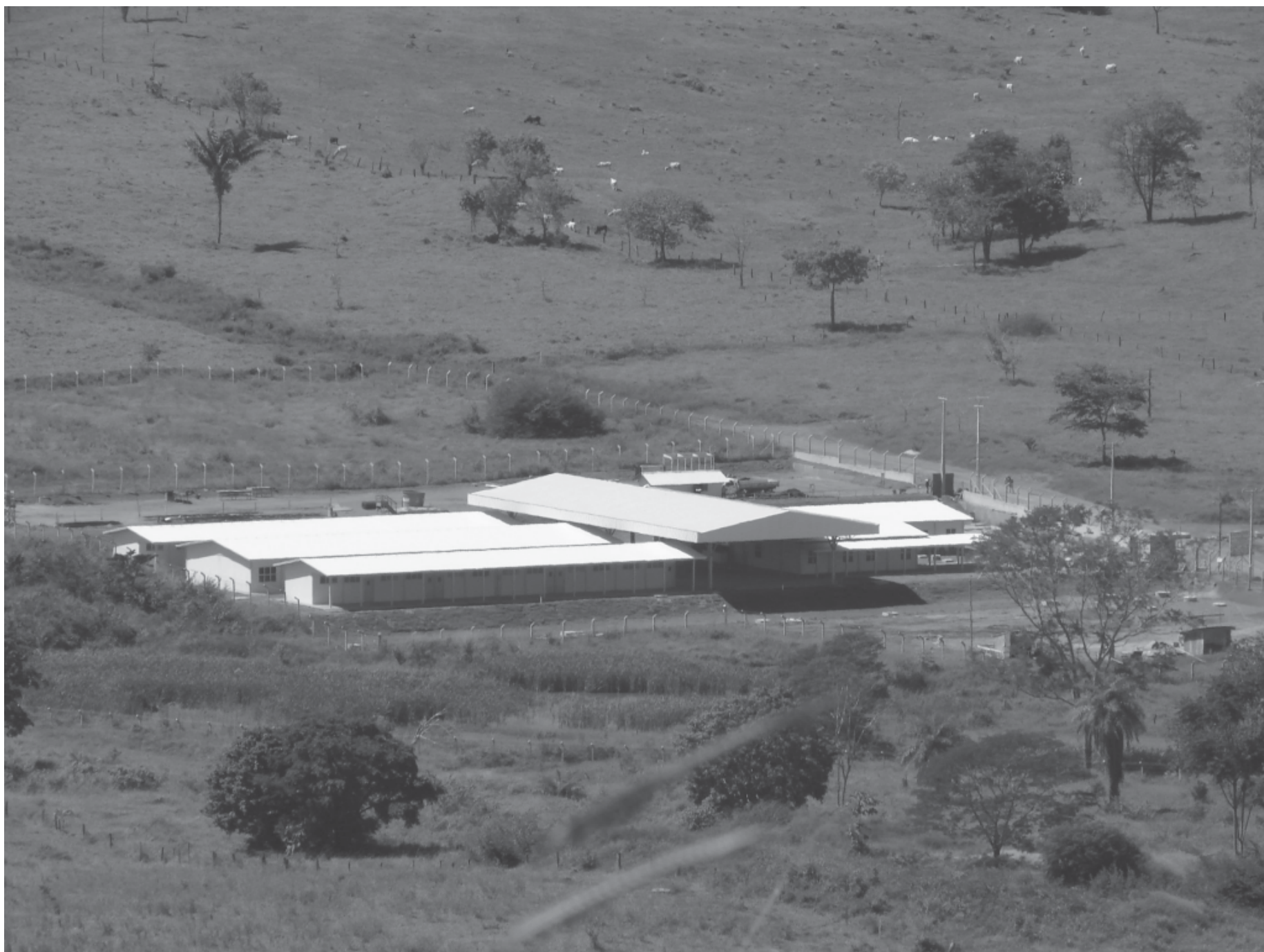
Figura 212 – Edifício da futura escola de formação profissional de Canaã, em fase de acabamento
