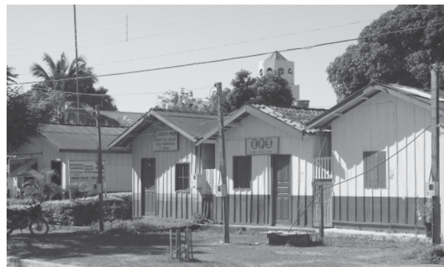
Figura 146 – Casa dos Engenheiros, 2007
