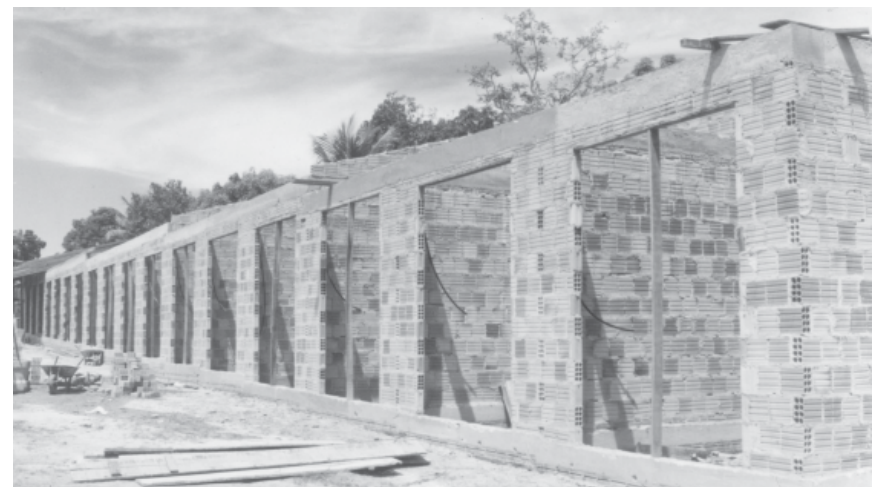
Figura 90 – Mercado Municipal, em construção
