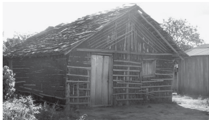
Figura 141 – Edificação, Vila Ouro Verde
