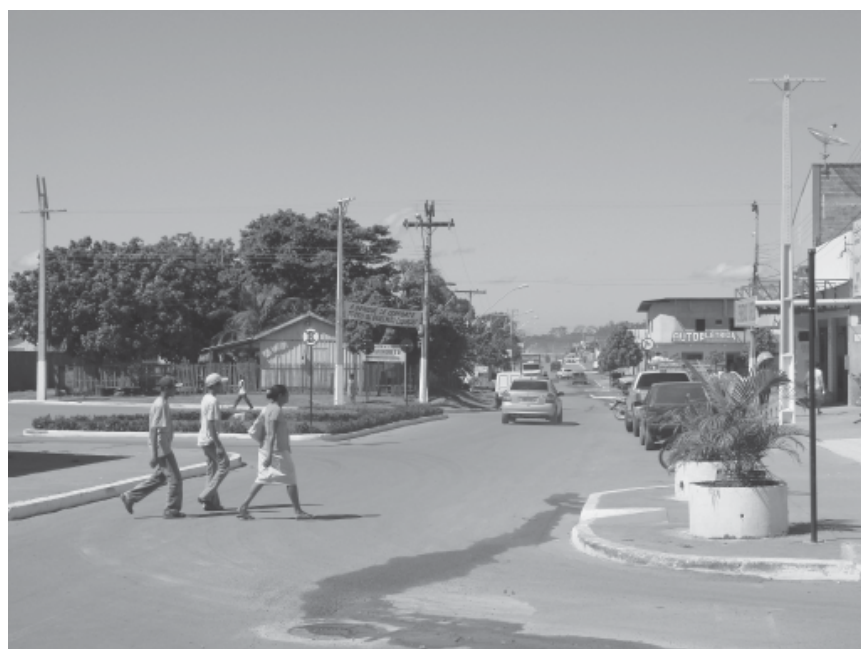
Figura 167 – Afunilamento na Avenida Weyne Cavalcante
