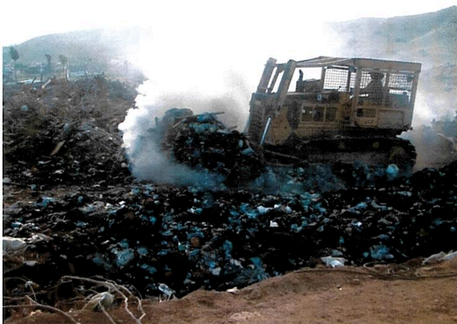
Figura 8.11 - Trator manejando e compactando os resíduos no lixão, com sinais de combustão da massa.
