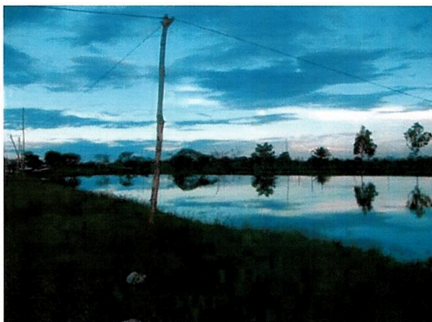
Figura 6.12 - Unidade de tratamento biológico do SES de Canaã dos Carajás - Lagoa facultativa.
