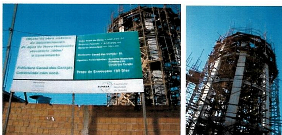
Figura 7 – Reservatório Elevado em construção – CR-E.
