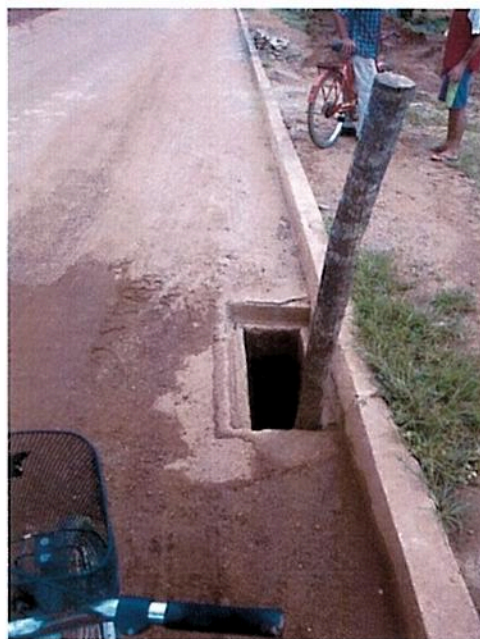
Figura 7.3 – Bueiro com tora de madeira
