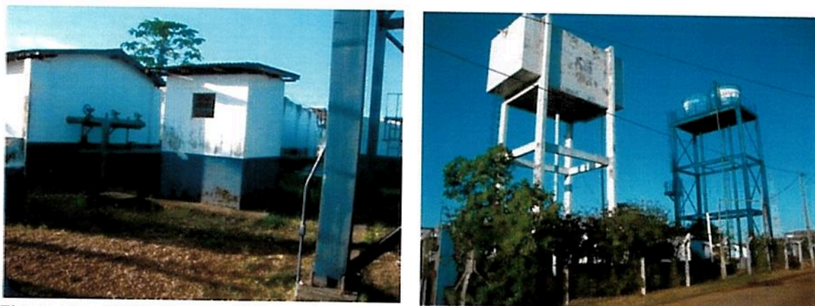
Figura 5.5 – EEAT, Reservatório apoiado e Reservatórios Elevados – CR B.
