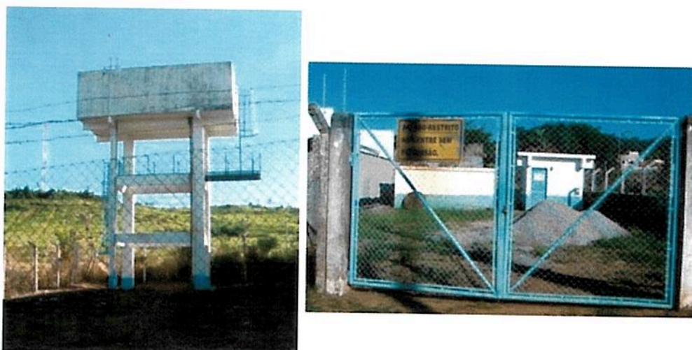
Figura 5.4 – Reservatório Elevado, Reservatório apoiado e EEAT – CRA.
