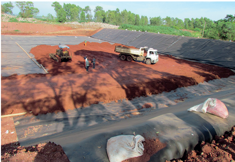
Implantação do Aterro Sanitário de Alegrete (RS).
