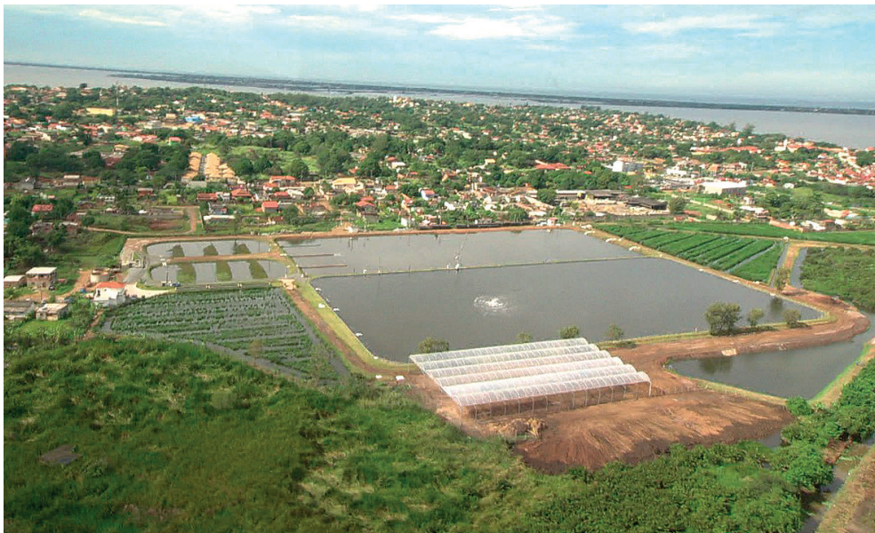
Maiores estação ecológica de tratamento de esgoto do Brasil fica em Araruama, Rio de Janeiro, com capacidade de tratamento de 200 litros por segundo.
