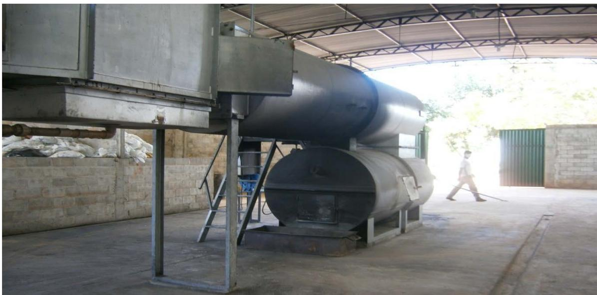
**Imagem 150:** Incinerador, filtro de gases e cortina d'água.
