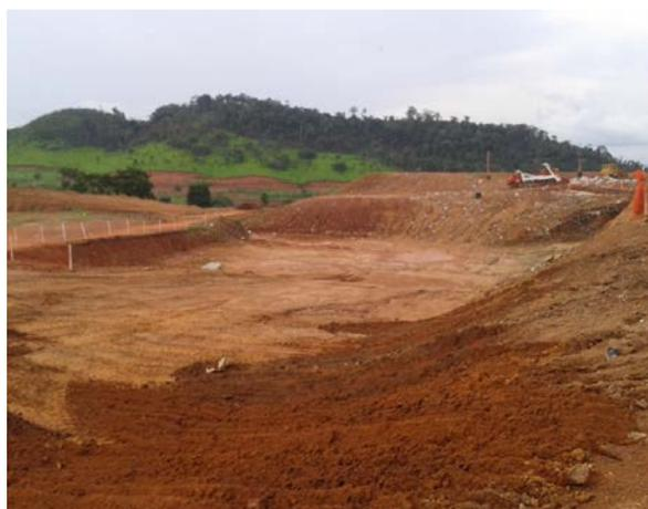
Conformação dos taludes laterais e do platô do aterro de maneira a se configurar as células para a disposição adequada dos resíduos sólidos e a delimitação geral do aterro com relação ao seu entorno.
